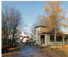
Bäume gefällt, Gebäude abgerissen: Die Bauarbeiten im Industriegebiet haben begonnen Fotos: cc
