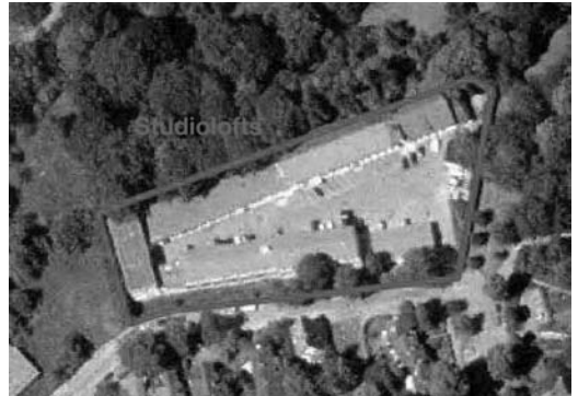
Der Gewerbehof am Borsteler Bogen aus der Luft. Im Vordergrund verläuft die Stavenhagenstraße.
