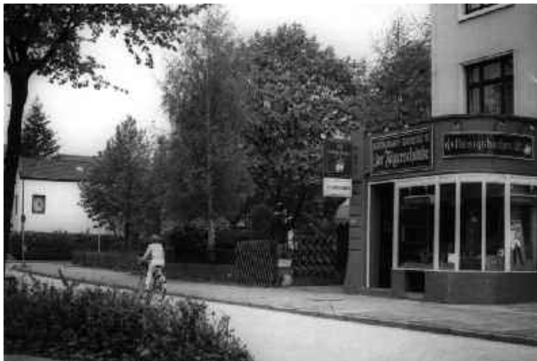
Borsteler Chaussee 168/Ecke Moorweg. Das Restaurant “Zur Jägerschänke” (siehe auch Luftbild auf der Titelseite) brannte 1988 ab. Das Grundstück lag viele Jahre brach.
